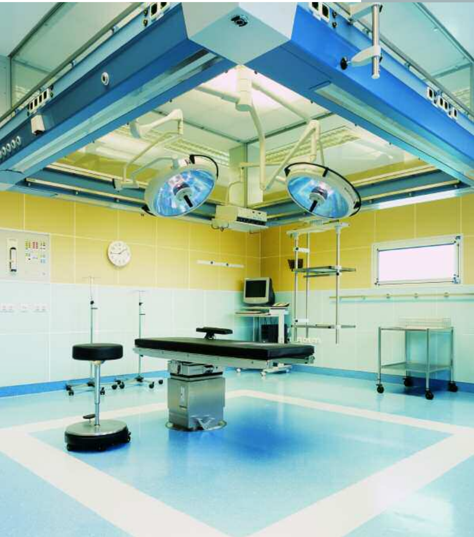
OP-Saal, Krankenhaus St. Bernhard, Hildesheim, Deutschland, Serie KerAion-OP-Spezialglasuren
