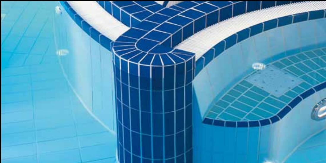
Die Ausführung der Sitzbank im Ocean Wave in Norddeich basiert auf konischen Zuschnitten. Sie besticht durch ihre hohe handwerkliche Qualität.
