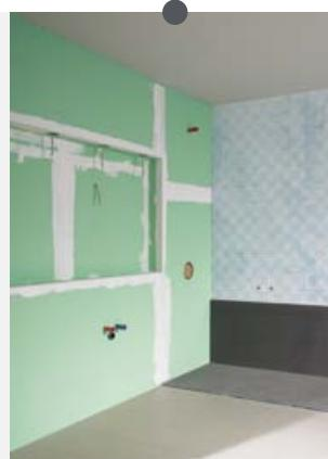
Vorbereitung: Trockenbauwand zur Aufnahme von Installationen einziehen, dann alte Fliesen entfetten, säubern und mit Grundierung behandeln. Das Abschlagen ersparen Sie sich.
