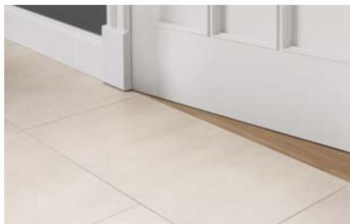
Mit flatile lassen sich Niveauunterschiede durch Türschwellen oder unterschiedlich hohe Bodenbeläge perfekt und problemlos ausgleichen. So entstehen absolut ebene Übergänge für ein sicheres und barrierefreies Wohnen.
