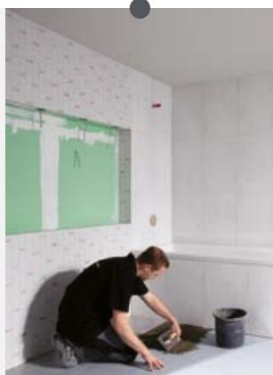
Boden zum Schluss: Einmal den Boden entfetten, anschließend säubern und mit Grundierung behandeln. Dann die Bodenfliesen verlegen. Fertig ist das „neue“ Badezimmer!
