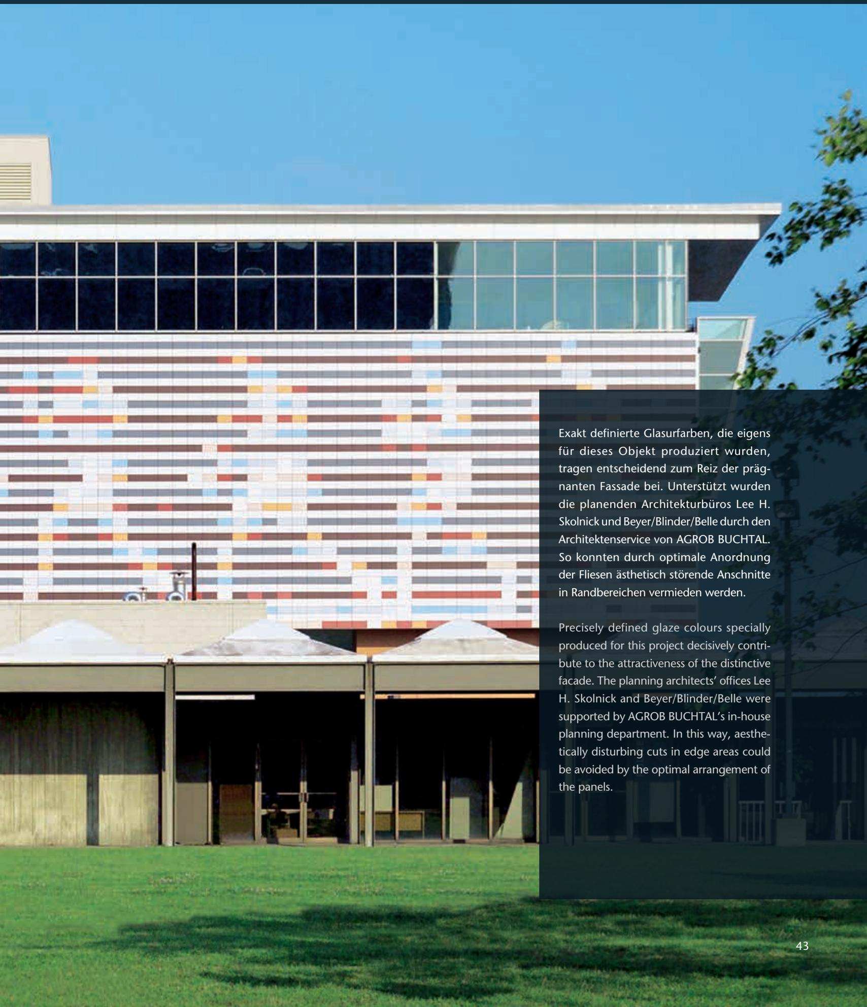
Exakt definierte Glasurfarben, die eigens für dieses Objekt produziert wurden, tragen entscheidend zum Reiz der prägnanten Fassade bei. Unterstützt wurden die planenden Architekturbüros Lee H. Skolnick und Beyer/Blinder/Belle durch den Architektenservice von AGROB BUCHTAL. So konnten durch optimale Anordnung der Fliesen ästhetisch störende Anschnitte in Randbereichen vermieden werden.
